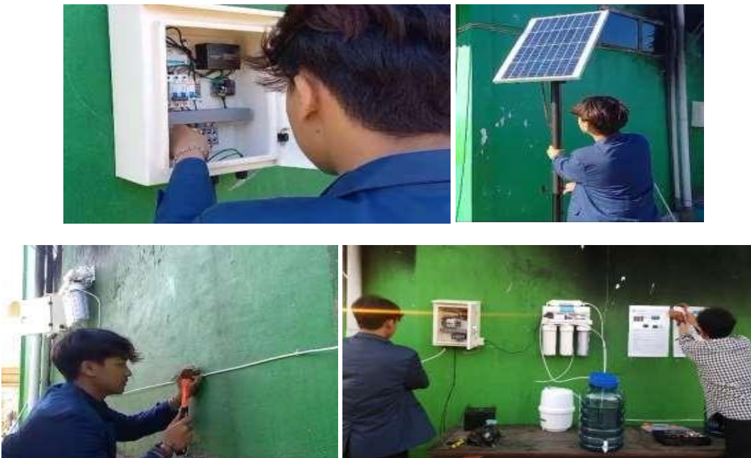
Gambar 3. Proses instalasi Mesin RO tenaga surya
