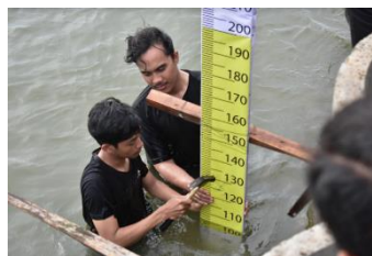
Gambar 2 Pemasangan rambu pengamatan tinggi muka (pealscale) air di posisi : 112.468039° BT, -6.891440° LS.
